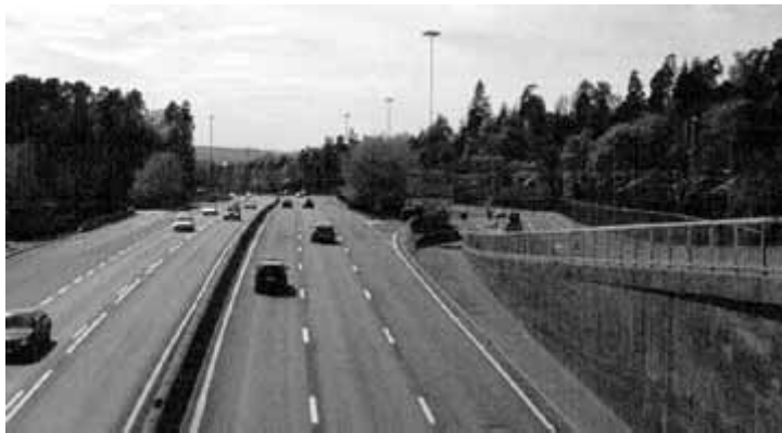
Rampen til høyre i bildet må flyttes ut mot E18.
