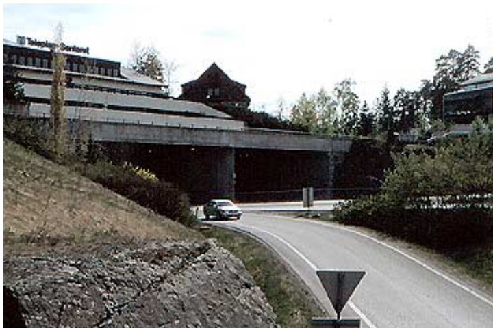
Fra utgangen av tunnelen kan man benytte høyre felt til trikketrasé.
