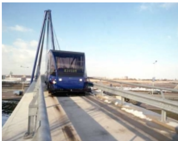
Figur 3.4. Egen bro över motorväg
